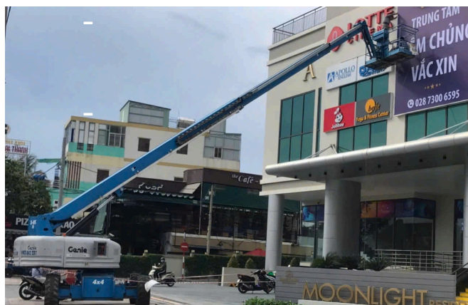
LẮP BIỂN QUẢNG CÁO
