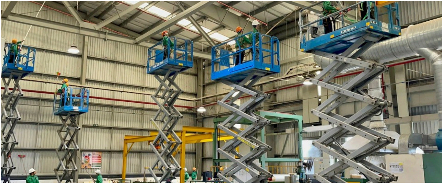
VỆ SINH NHÀ XƯỞNG TẠI KCN LỘC AN
